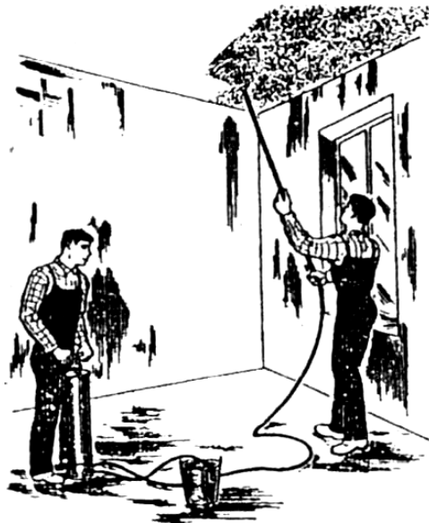
Рис. 4. Грунтування поверхонь вудкою фарбопульту
