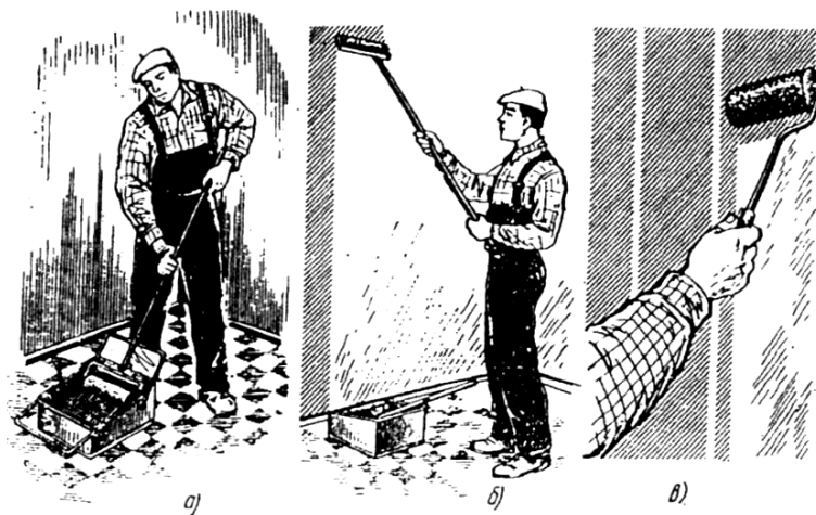
Рис. 3. Нанесення складу ґрунтовки валиками:
